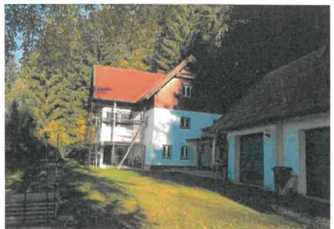
Gebäude mit An- und Zubauten
